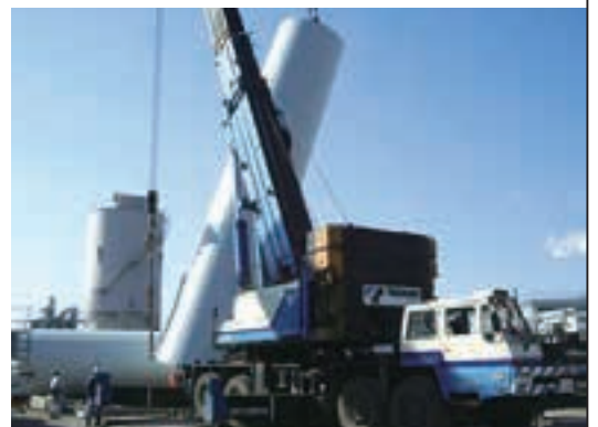
重機による大型重量物の据付け
