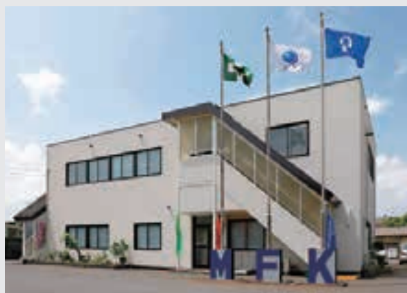
JFEメカフロント倉敷事務所
