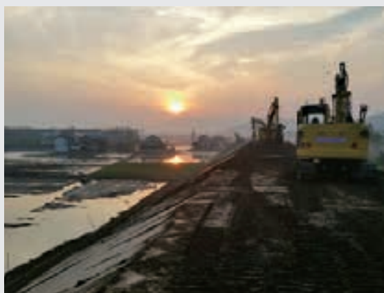
2018年7月 西日本豪雨災害復旧工事
