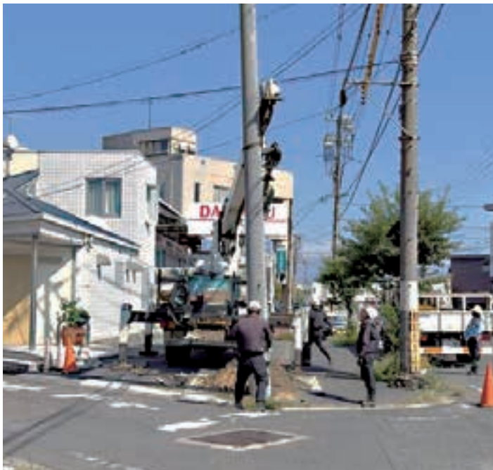
作業中の様子
