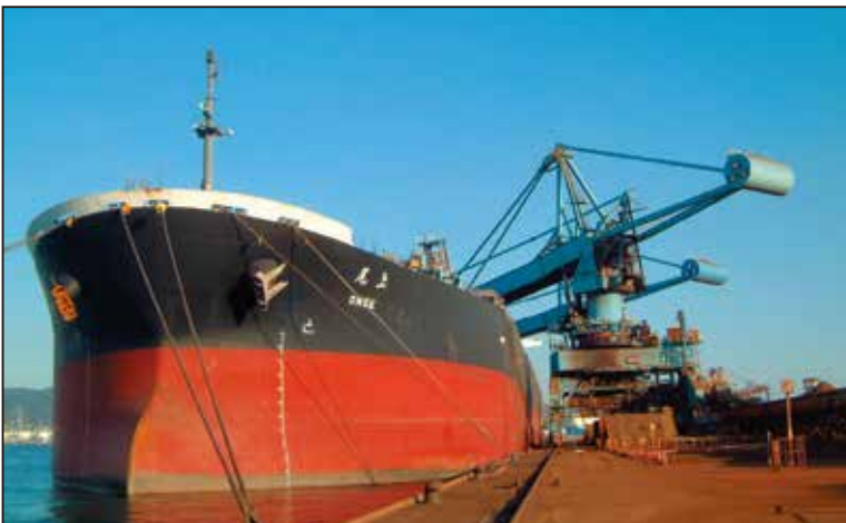
原料を荷揚げする連続式アンローダー
