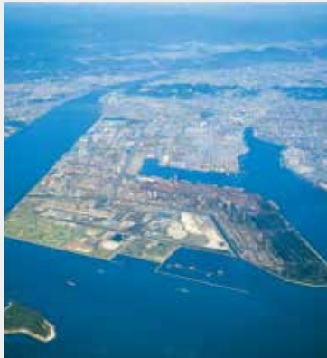
西日本製鉄所(倉敷地区)全景
