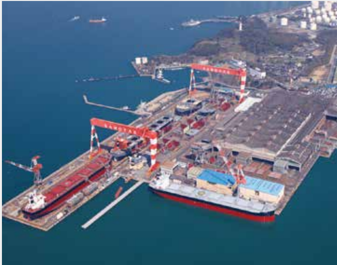
水島製造所全景
