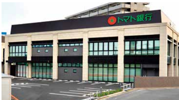
トマト銀行倉敷営業部新築工事(倉敷市中央)
