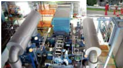
回転機械据付・メンテナンス
