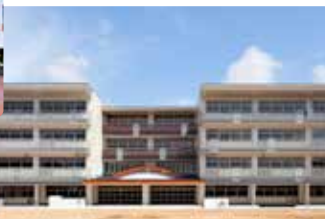
倉敷市立老松小学校 校舎建築工事
