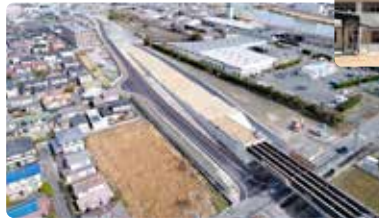
岡山環状南道路大福地区第6改良工事
