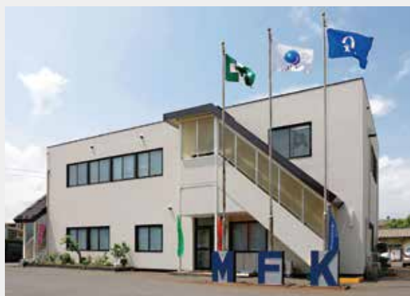
JFEメカフロント倉敷事務所
