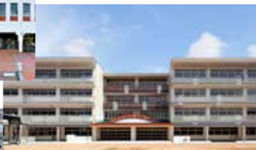
倉敷市立老松小学校 校舎建築工事
