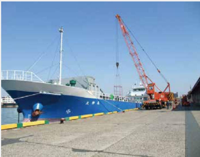
水島港作業風景
