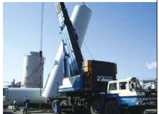
重機による大型重量物の据付け
