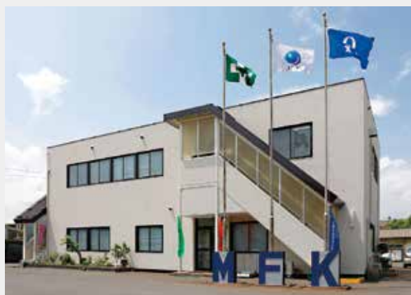
JFEメカフロント倉敷事務所
