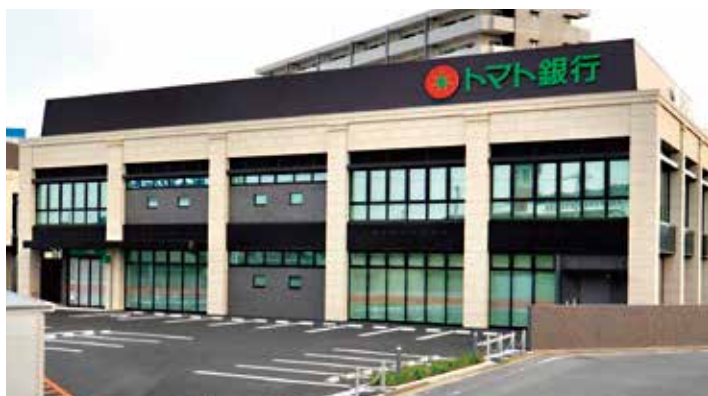
トマト銀行倉敷営業部新築工事(倉敷市中央)
