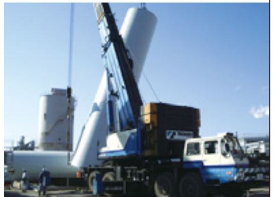
重機による大型重量物の据付け
