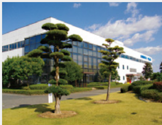
倉敷工場外観
