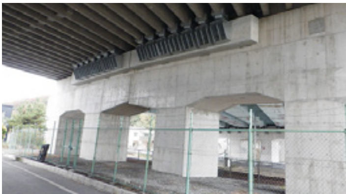
連島2号高架橋橋桁落下防止工事(倉敷市連島)
