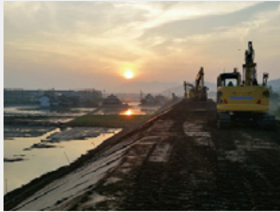
2018年7月 西日本豪雨災害復旧工事
