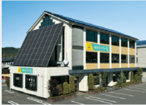
中本屋工務店 本社屋
