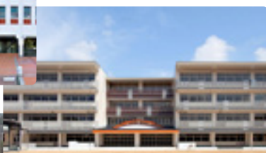
倉敷市立老松小学校 校舎建築工事
