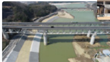
令和3年度小田川付替柳井原地区護岸第2工事
