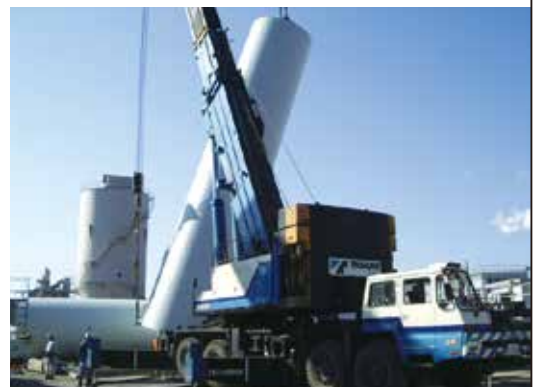
重機による大型重量物の据付け
