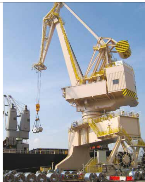
JFE構内作業風景
