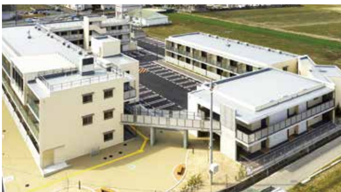
倉敷市真備町川辺地区災害公営住宅等整備事業(倉敷市真備町川辺)
