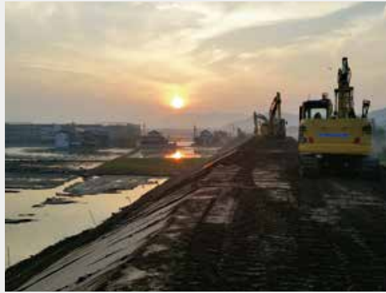
2018年7月 西日本豪雨災害復旧工事
