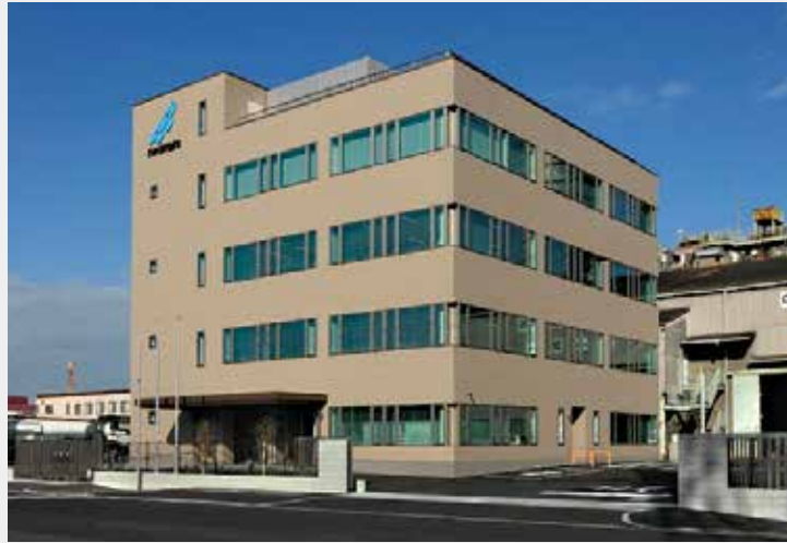
水島本社新社屋全景
