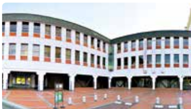
倉敷市庁舎低層棟耐震補強建築工事
