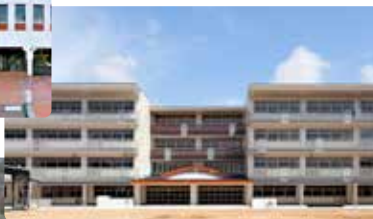
倉敷市立老松小学校 校舎建築工事
